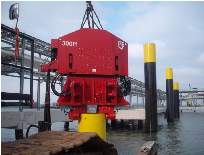
Equipo de vibro-hincado, hincando camisa metálica
